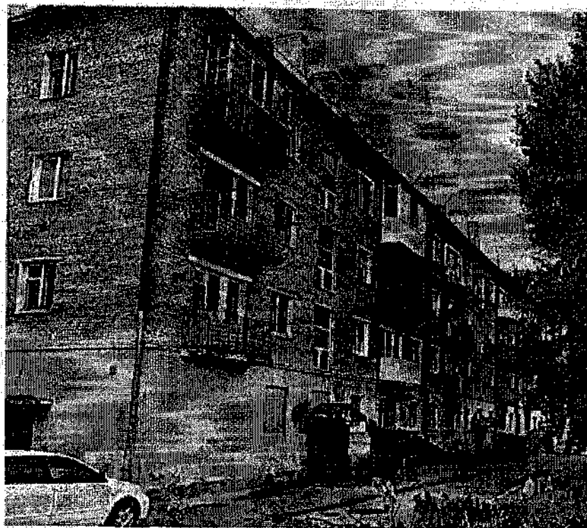
Фото Б2. Дворовой фасад здания.
